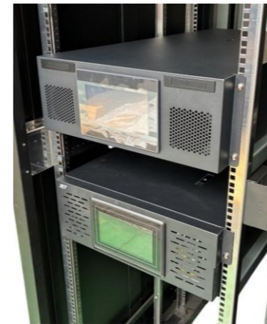
CDU・水冷サーバー サーバー等機器調達・コーディネート
