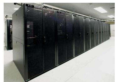
空調・電機・電源・通信システム施工 水冷管工事
